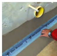
10 / Do prvého náteru vtláčime Tesniacie pásy a rohy.
