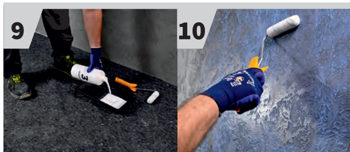
9 NATURAL aplikácia uzatváracej vrstvy
