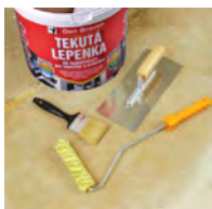
8 / Pripravíme si náradie – valček, štetec, oceľové hladítko.
